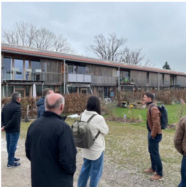
Mehrgenerationenwohnen Pallauhof, Münsing
